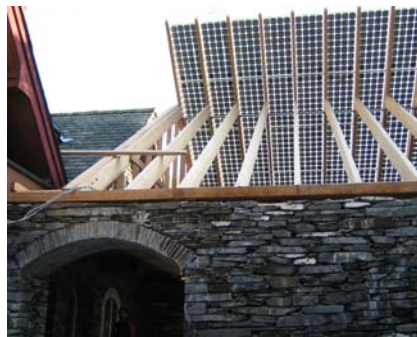
17 pav. Iš dalies užtamsinti stiklai su įmontuotais fotoelementais.
