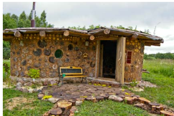
41 pav. Vilniaus rajone esančios pirtelės sienos sumūrytos iš apvalių malkų, naudojant molio skiedinį, stogas apželdintas. J. Pečiulio nuotr.
