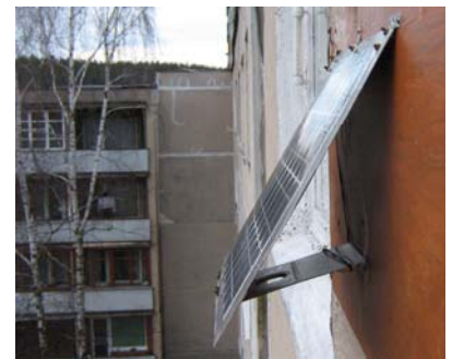
18 pav. Fotoelementų modulis ant daugiabučio namo.
